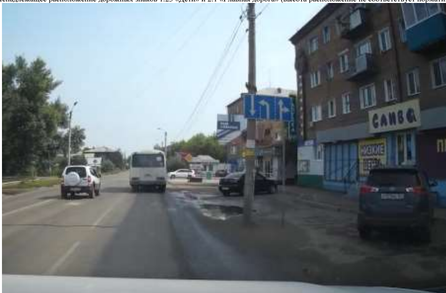
Рисунок 5.11 – Применение дорожного знака, не соответствующего классификации ГОСТ 52290-2004 на ул. Московская
