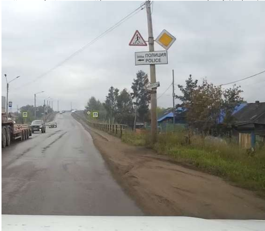
Рисунок 5.10 – Ненадлежащее расположение дорожных знаков 1.23 «Дети» и 2.1 «Главная дорога» (высота расположения не соответствует нормативным документам)
