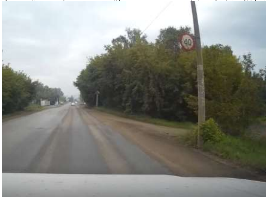
Рисунок 5.9 – Недостаток эксплуатационного состояния дорожного знака 3.24 «Ограничение максимальной скорости» ул. Декабристов (знак загрязнен)
